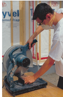
Příklad řezání cihel suchým řezem
